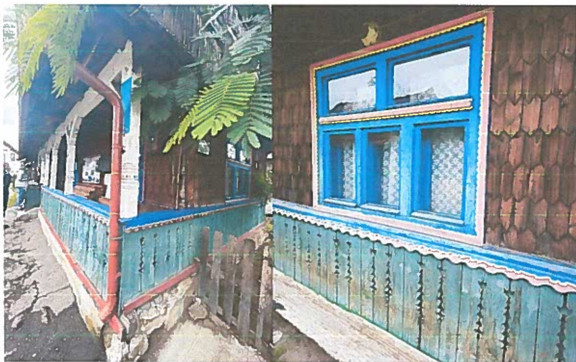
Fig. 3-4: Detalii soclu, închidere și stâlpi prispă casă memorială Ioan Stan Pătraș.
